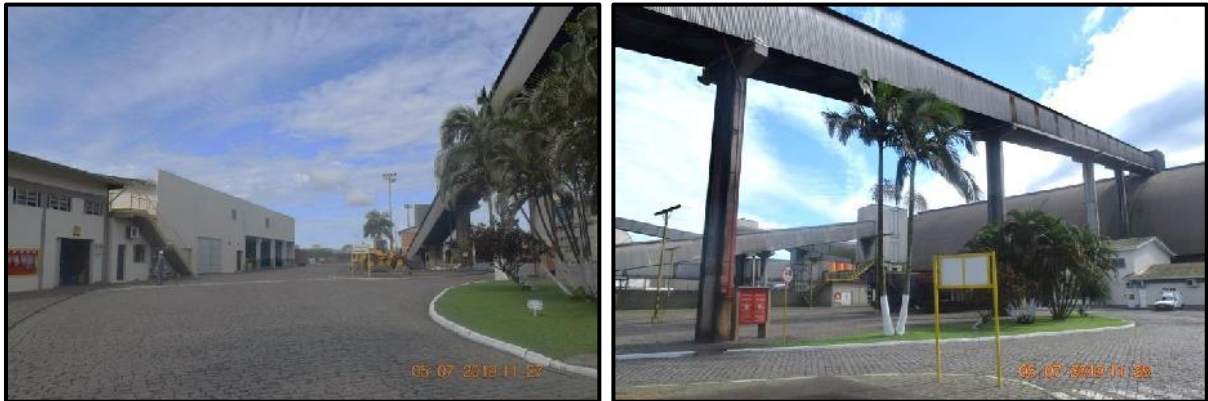
Figura 38 - Palmeiras exóticas existentes no imóvel das unidades I, II e III.
