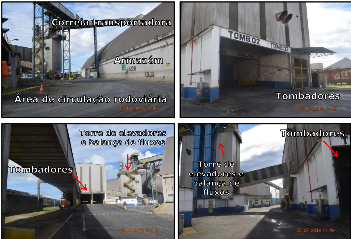
Figura 15 – Estruturas da unidade II.
