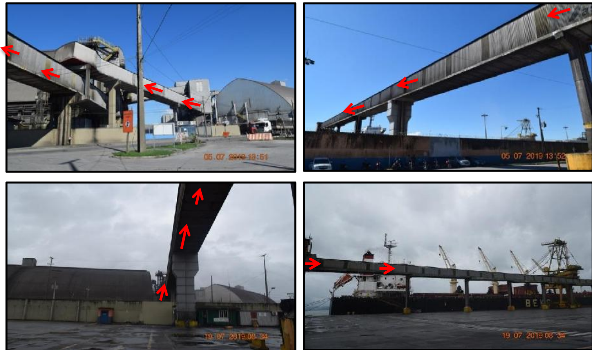
Figura 10 – Expedição do produto por correias transportadoras entre os armazéns e os shiploaders berços 203 e 204, situados no cais público do Porto de Paranaguá, e conseguinte carregamento de navio.
